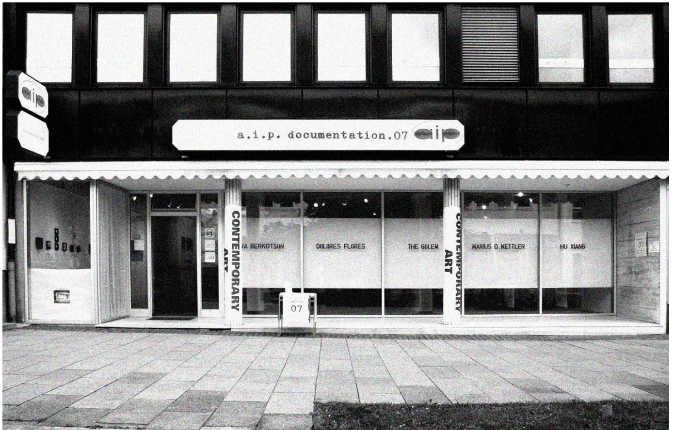
Vorzügliche Zwischennutzung: a.i.p. präsentiert sich an bester Stelle in Kasseler Innenstadt
